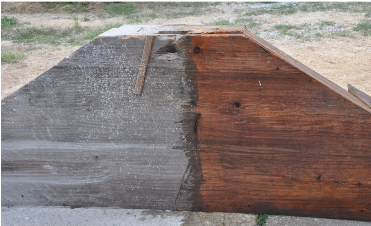
Detail čistenie od depozitov a usadenín
