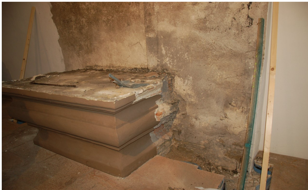
Stav po demontáži architektonickej zložky
