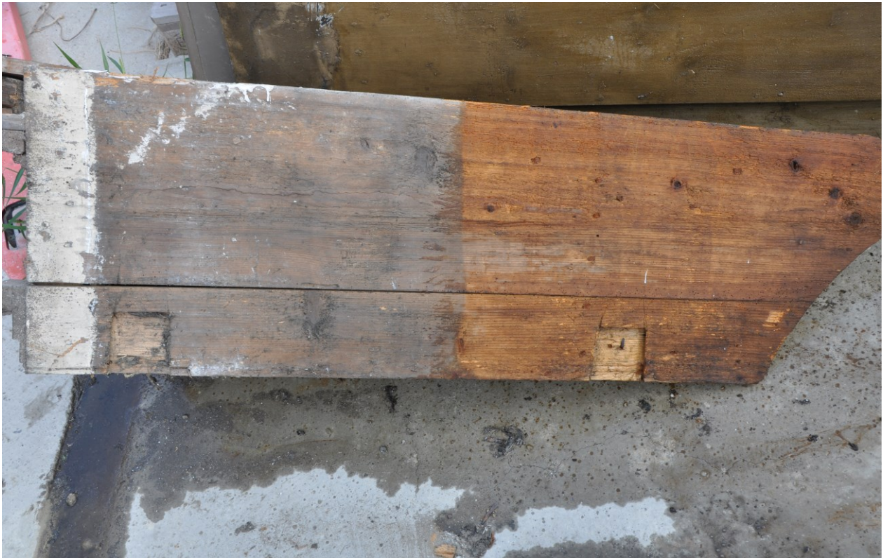
Čistenie od depozitov a usadenín
