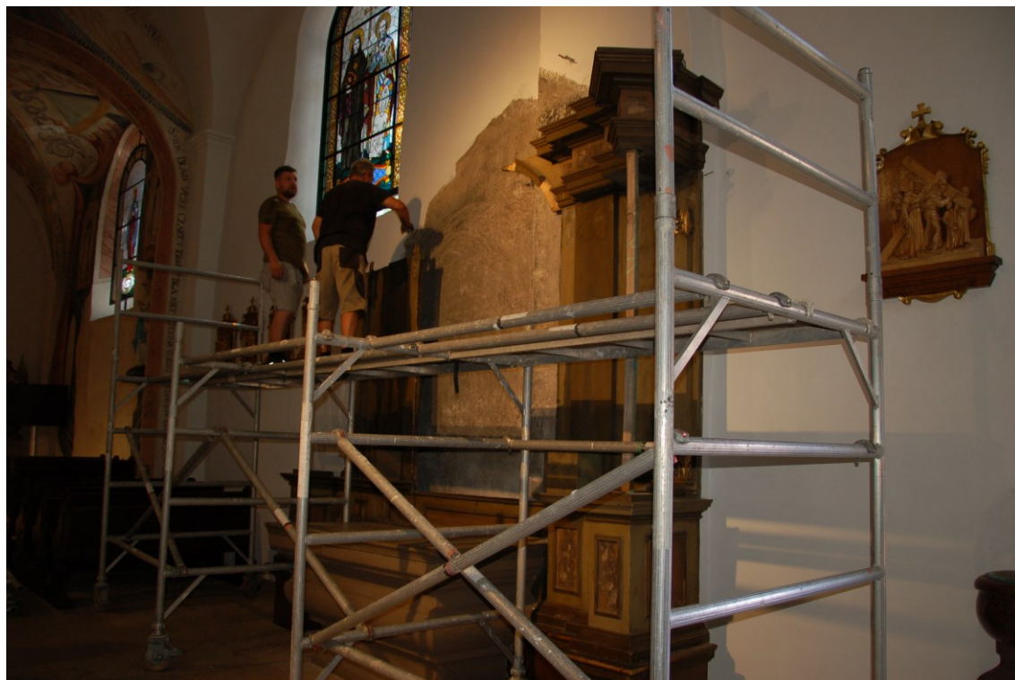
Demontáž architektonickej zložky
