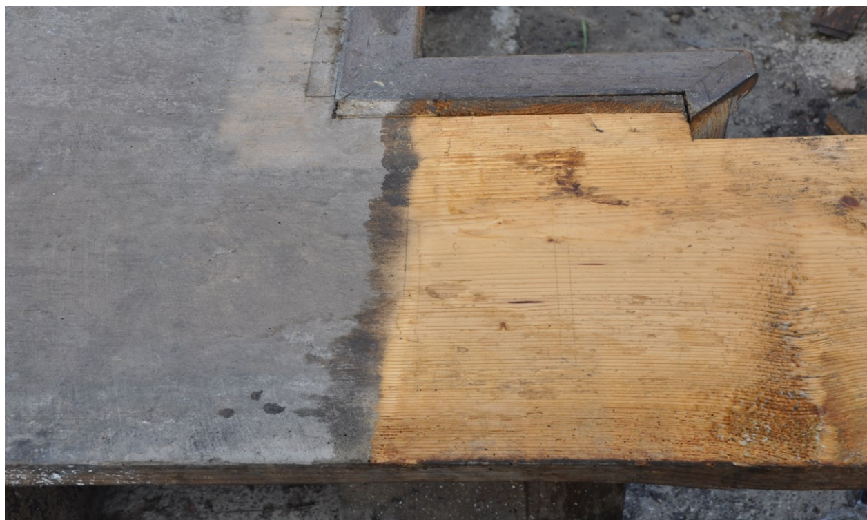
Čistenie od depozitov a usadenín
