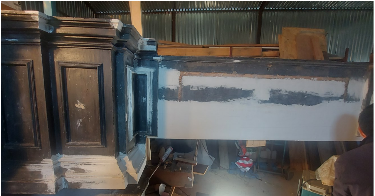
Tmelenie a tvarové zjednotenie architektúry predely
