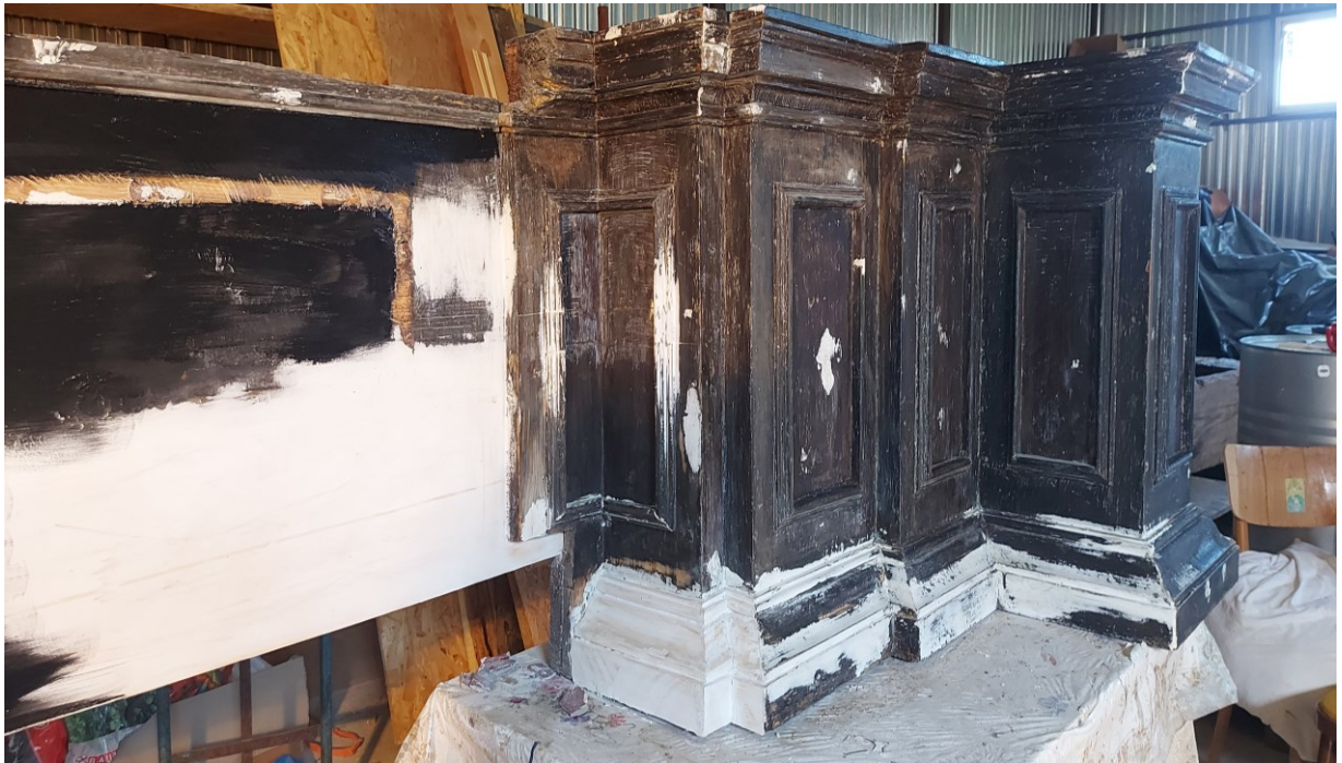
Tmelenie a tvarové zjednotenie architektúry predely
